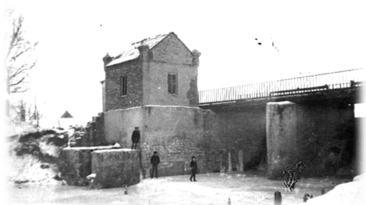
Перекоповская ГЭС, 1972 г. https://ok.ru/seloperekopovka
